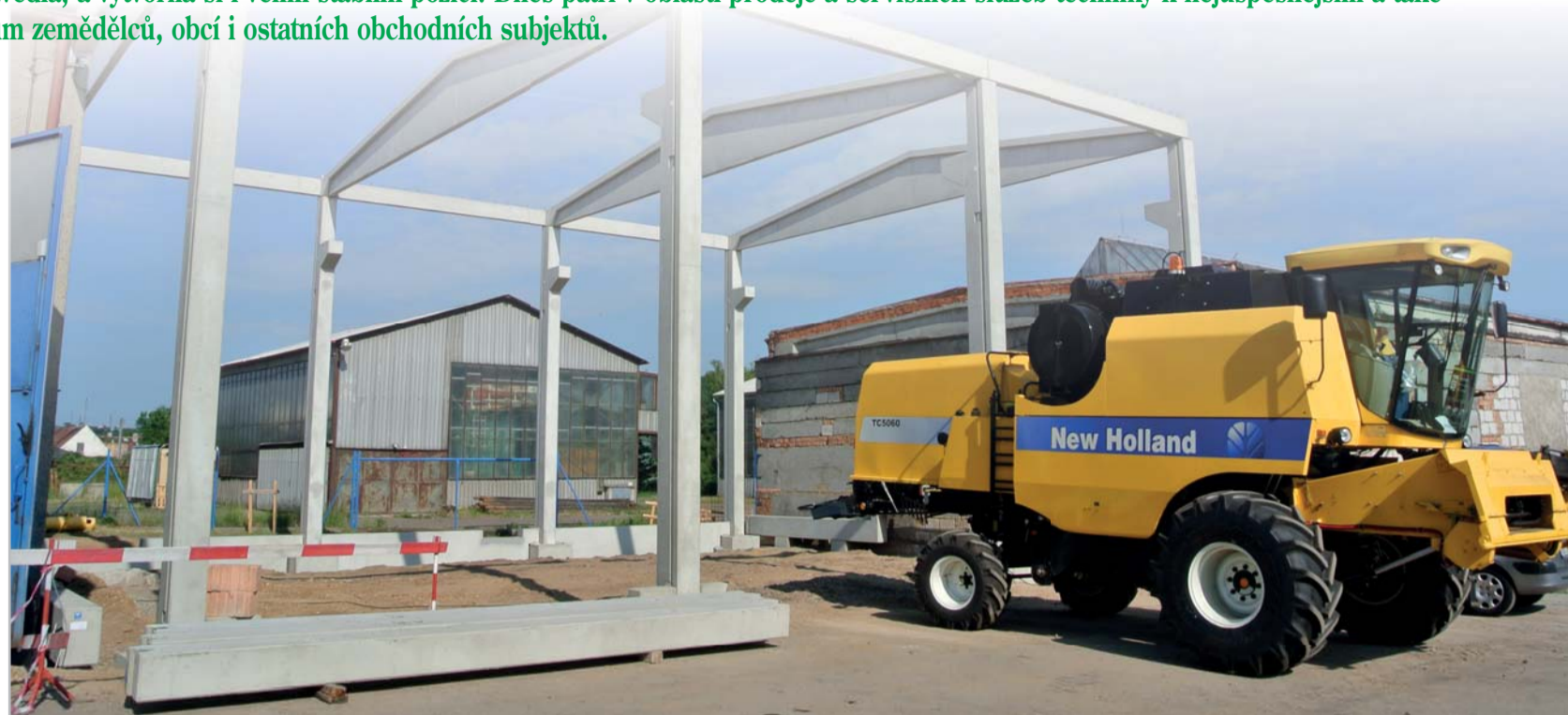
Nová hala, projektovaná pro opravy i té největší techniky v době výstavby ...
